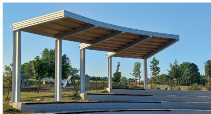
Nova nadstrešnica pri Srednji šoli Črnomelj povezuje šolo, vrtec in lokalno skupnost.
